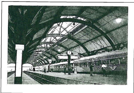
Bild 4: Bahnhofshalle Malmö, vierschiffige Halle, Spannweite: 17,9 m, 1923 errichtet, (Foto: C. Magnusson, Malmö)
